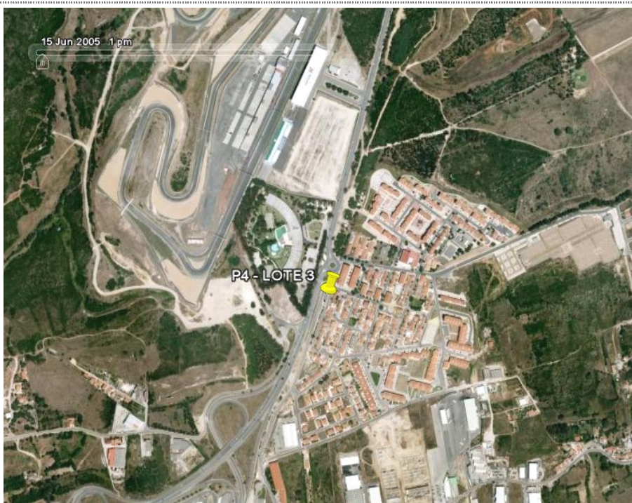
Figura 4 – Fotografia aérea da envolvente próxima de P4.
